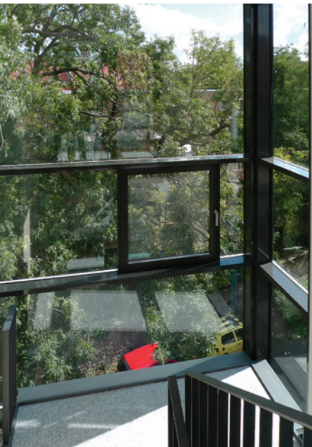
Das neue Treppenhaus von innen
