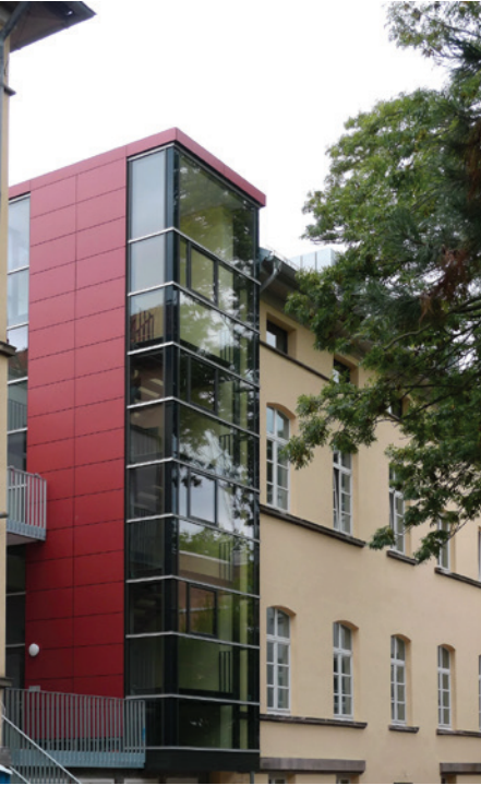
Einzigster Anbau: das neue Treppenhaus zum Hof
