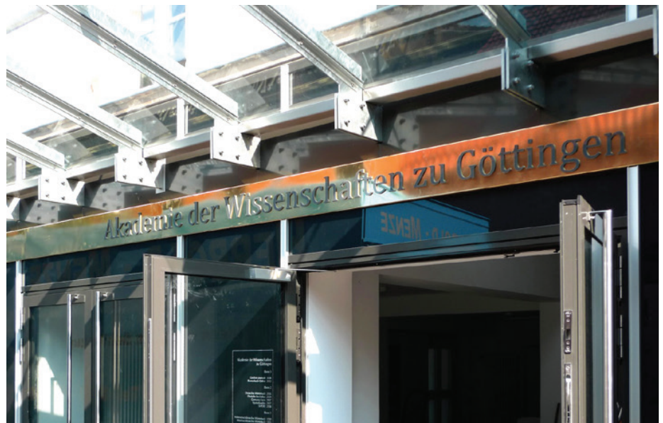
Der neue Eingang zur Geiststraße 10
