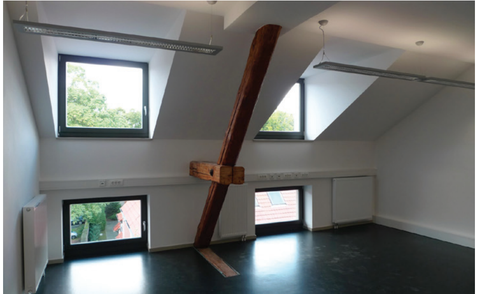
Lösung für mehr Licht: Büro unterm Dach mit zusätzlichen Fenstern am Boden
